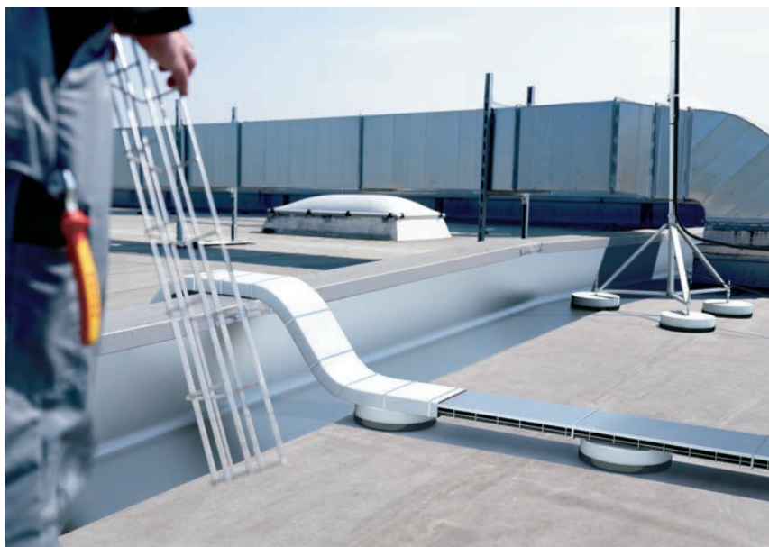
Zaštićeno svladavanje protupožarnog zida pomoću protupožarne bandaže
