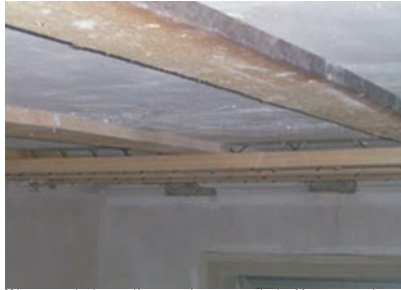
Strop od drvenih greda u postojećim zgradama
