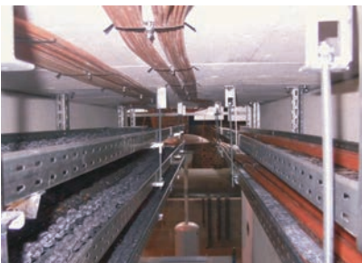
Montaža sustava za ispitivanje očuvanja funkcije
