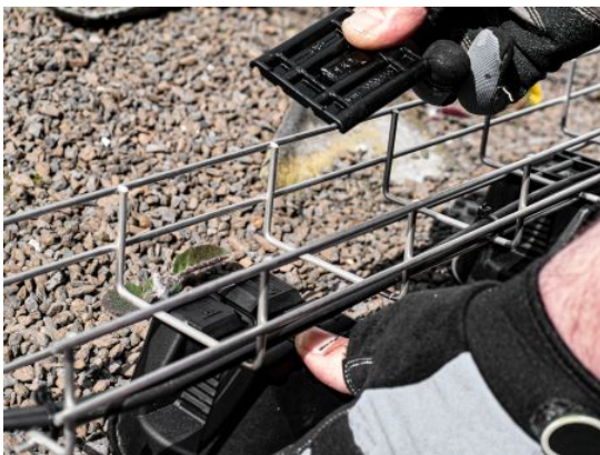
Slika 12. Pričvršćivanje adaptera
