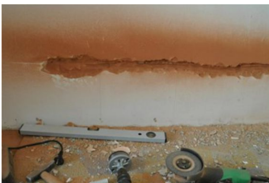
Slika 8. Spoj kutnog i instalacijskog kanala
